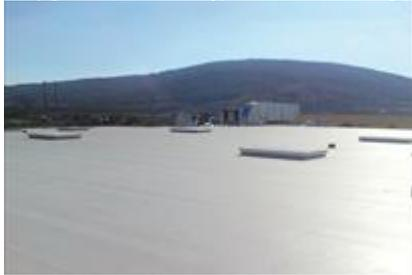
I cool roof sono coperture che hanno una elevata capacità di riflettere l'irradiazione solare incidente e contemporaneamente emettere energia termica nell'infrarosso, hanno cioè una elevata riflettanza solare ed una elevata emissività termica. I cool roof sono coperture caratterizzate da una bassa temperatura superficiale, anche sotto irraggiamento solare diretto.
